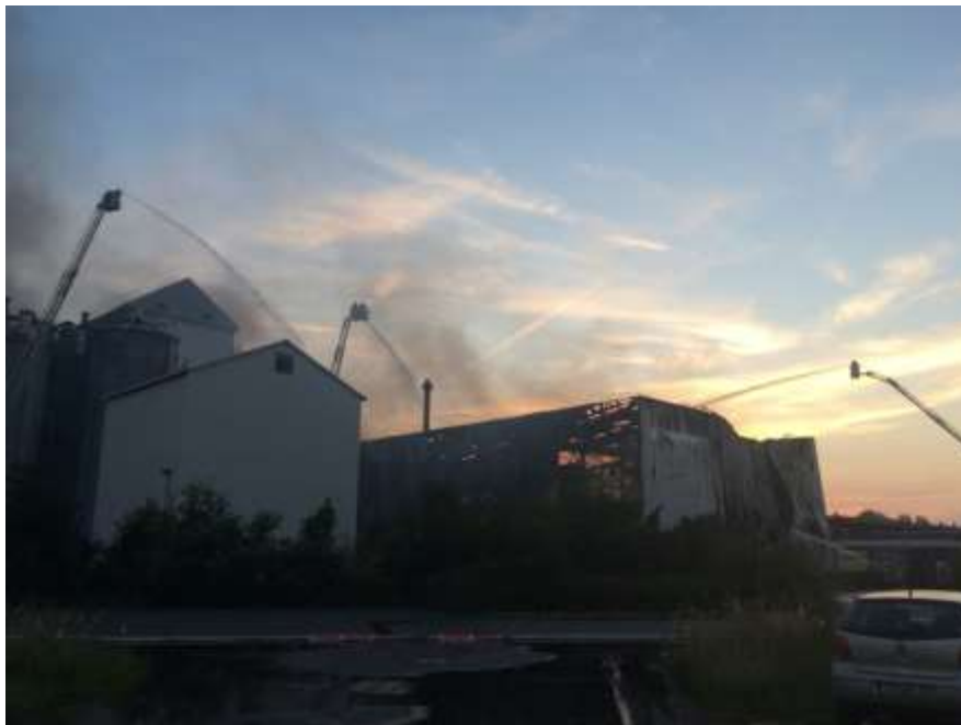
(Einsatz von 3 Drehleitern als Riegelstellung bei einem Hallenbrand)
